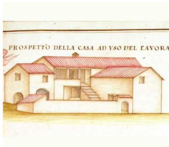
Chianti Senese: casa diacronica di origine medievale e moderna a corte, 1709 (A. Ruini, Archivio di Stato di Siena)
