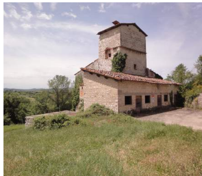
Nipozzano: casa con torre medievale (foto A. Guarducci)
