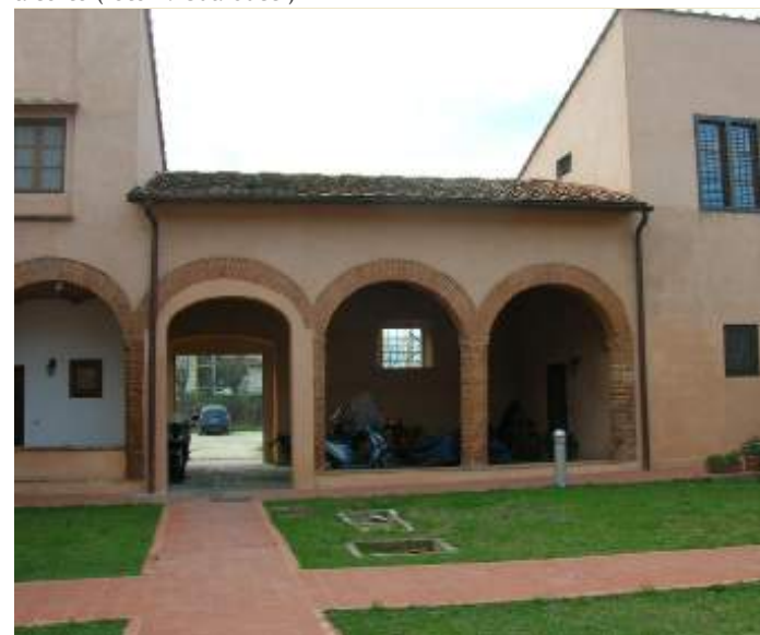
Piana Fiorentina: casa diacronica di origine medievale e moderna a corte, pesantemente ristrutturata (foto A. Guarducci)
