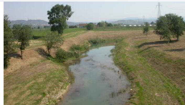
Artificializzazione del basso corso di fiumi e torrenti con l'eliminazione della vegetazione ripariale e la riduzione delle funzioni ecologiche e paesaggistiche: Fiume Cornia (Foto L. Lombardi, archivio NEMO)
