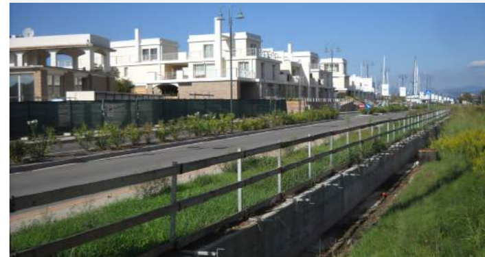
Nuovo edificato residenziale complementare alla realizzazione del porto turistico di Scarlino (Loc. Portiglione), con trasformazione dell'area costiera ed isolamento delle aree naturali e seminaturali costiere (foto L. Lombardi, archivio NEMO)
