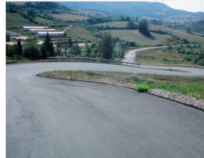
Nuovo asse stradale di collegamento tra Badia di Moscheta e Firenzuola (variante legata al progetto alta velocità ferroviaria), in attraversamento della Valle del Torrente Viola, nell'ambito del Sito Natura 2000 "Conca di Firenzuola". (Foto: L. Lombardi, archivio NEMO)
