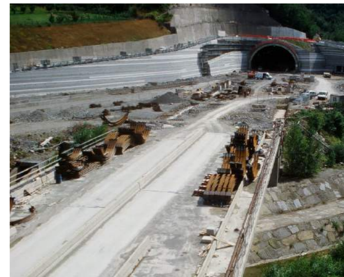
Cantiere della linea ferroviaria ad alta velocità Firenze-Bologna (TAV) in attraversamento del Torrente Santerno in Loc. San Pellegrino. (Foto: L. Lombardi, archivio NEMO)
