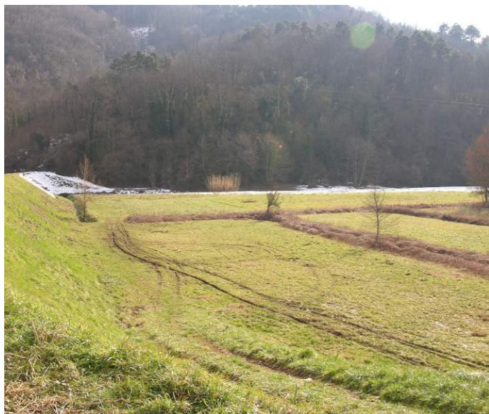
Mitigazione del rischio idraulico: cassa di espansione in Val Freddana
