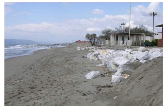
Effetti dell'erosione costiera sul litorale apuano (Foto B. Baldi)
